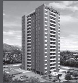
Edificio Centro Macul
