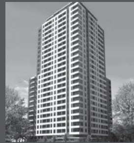
Edificio San Isidro
