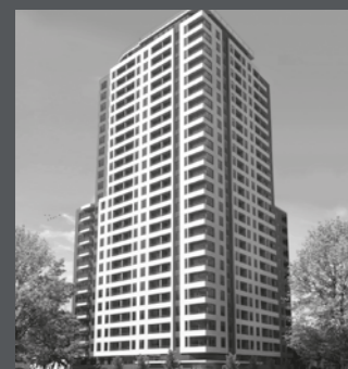
Edificio San Isidro
