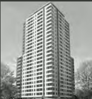
Edificio San Isidro
