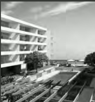
Edificio Bordemar Los Molles
