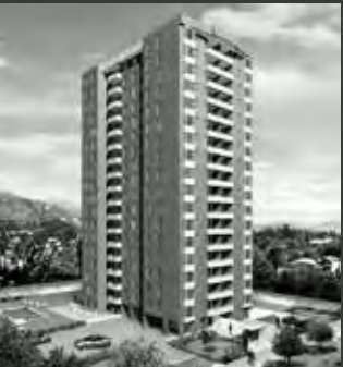
Edificio Centro Macul
