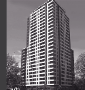
Edificio San Isidro
