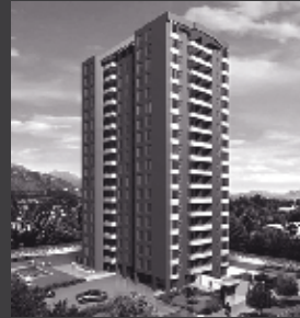
Edificio Centro Macul
