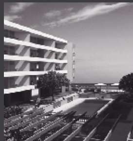
Edificio Bordemar Los Molles
